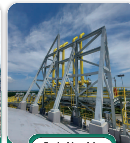
Dự án kho chứa LNG Thị Vải
