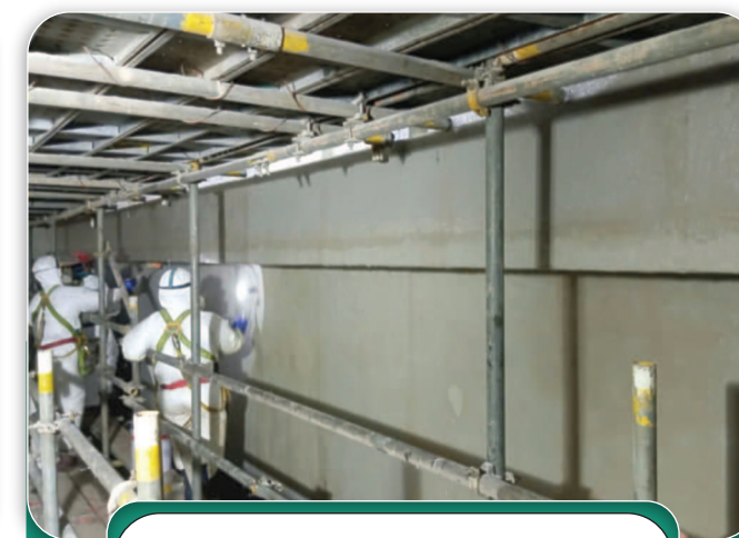
Dự án Nhà máy Nhiệt điện Vũng Áng II
