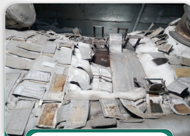
Dự án Nhà máy Điện Cà Mau 1 & 2
