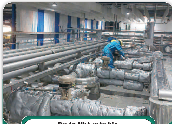
Dự án Nhà máy bia HEINEKEN Đà Nẵng
