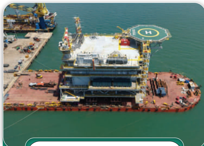
Dự án Giàn điện gió OSS Topside - PV Shipyard
