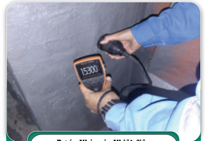
Dự án Nhà máy Nhiệt điện Duyên Hải 3 Mở rộng
