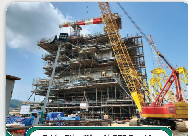
Dự án Giàn điện gió OSS Topside - PV Shipyard
