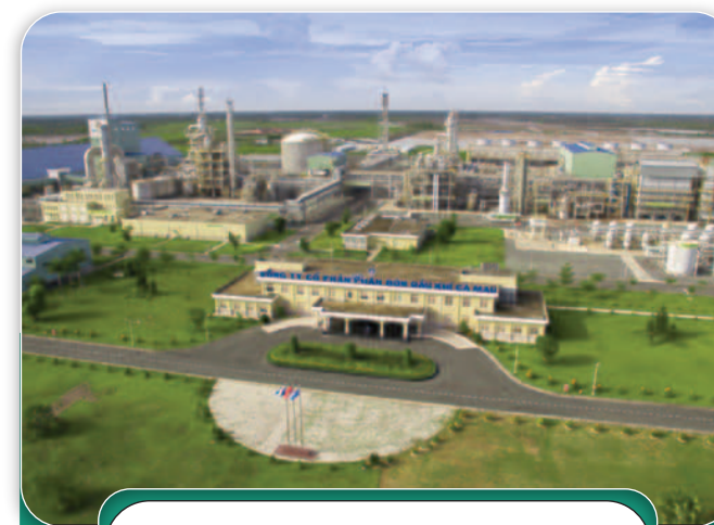
Dự án Nhà máy Đạm Cà Mau
