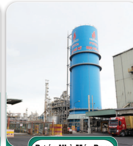
Dự án Nhà Máy Đập Phú Mỹ
