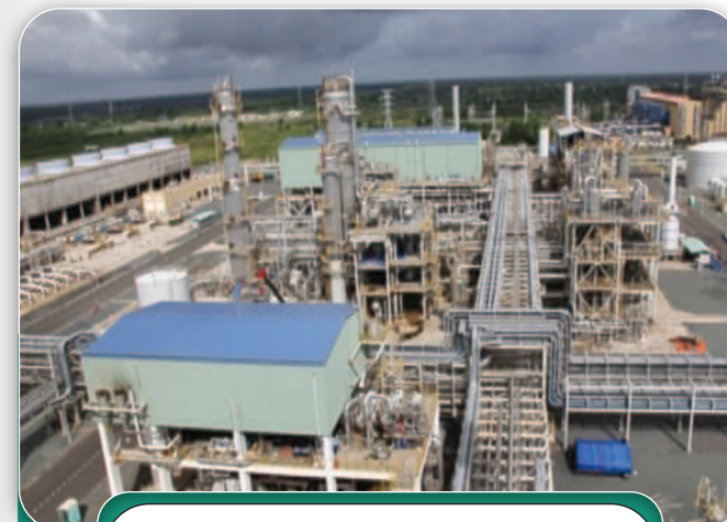
Dự án Nhà máy Đạm Cà Mau
