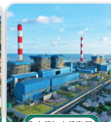
Dự án Nhà máy Nhiệt điện Duyên Hải 3 Mở rộng
